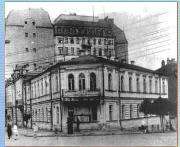
Будівля Гідрометеорологічної служби України Київ, 1920-1930-ті роки.
