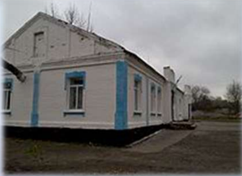
Будівля Новоприлуцької школи, де раніше був хедер
