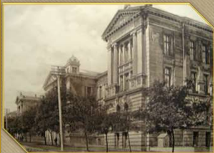
Головний корпус медичного факультету на поч. ХХ ст. Фото з сайту: https://bit.ly/3NUEtsf
